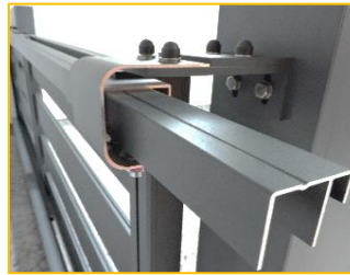
Guide-olives et barres de guidage haut refoulement à droite
