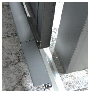
Barres de guidage bas Refoulement à droite vue intérieure
